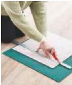
割付け後、部屋の形に合わせてカットします。側面から糸の芯材が出る場合があります。ハサミでカットしてください。
